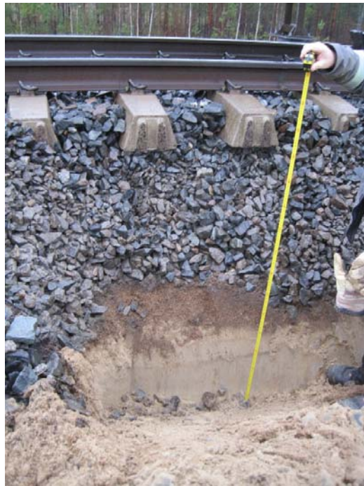
Kuva 43 Radan rakennekerrokset pehmeikkökohteessa P86.
