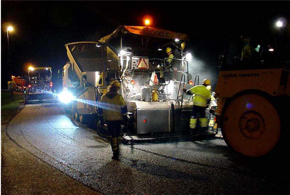
Kuva 7. Koetien päällystemassojen levitys yöllä kahdella levittimellä (Korson ramppi Lahden väylälle Helsingin suuntaan).
