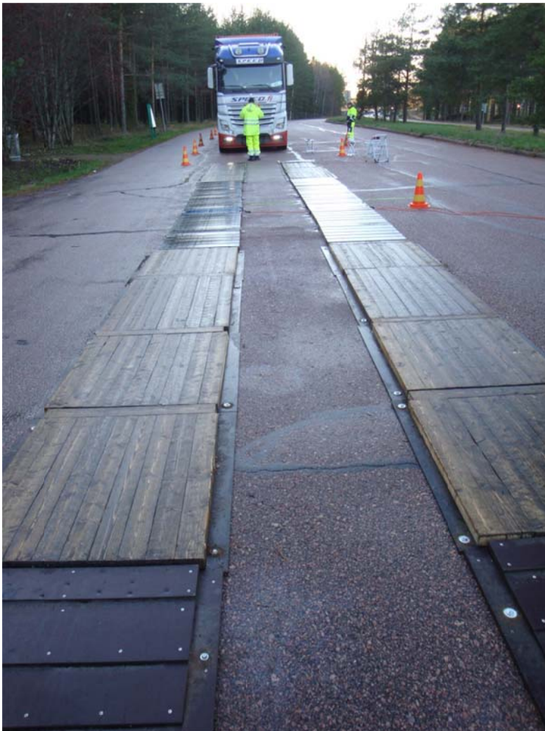
Kuva 6. Akselivaa'an ympärille rakennetut ajorampit.
