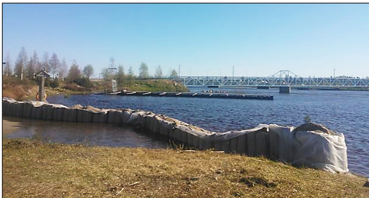
Kuva 10.5. Hiekkasäkeistä tehty tilapäinen tulvapenger suursäkkien käyttöharjoituksissa Torniossa (kuva Ari Soppela)
