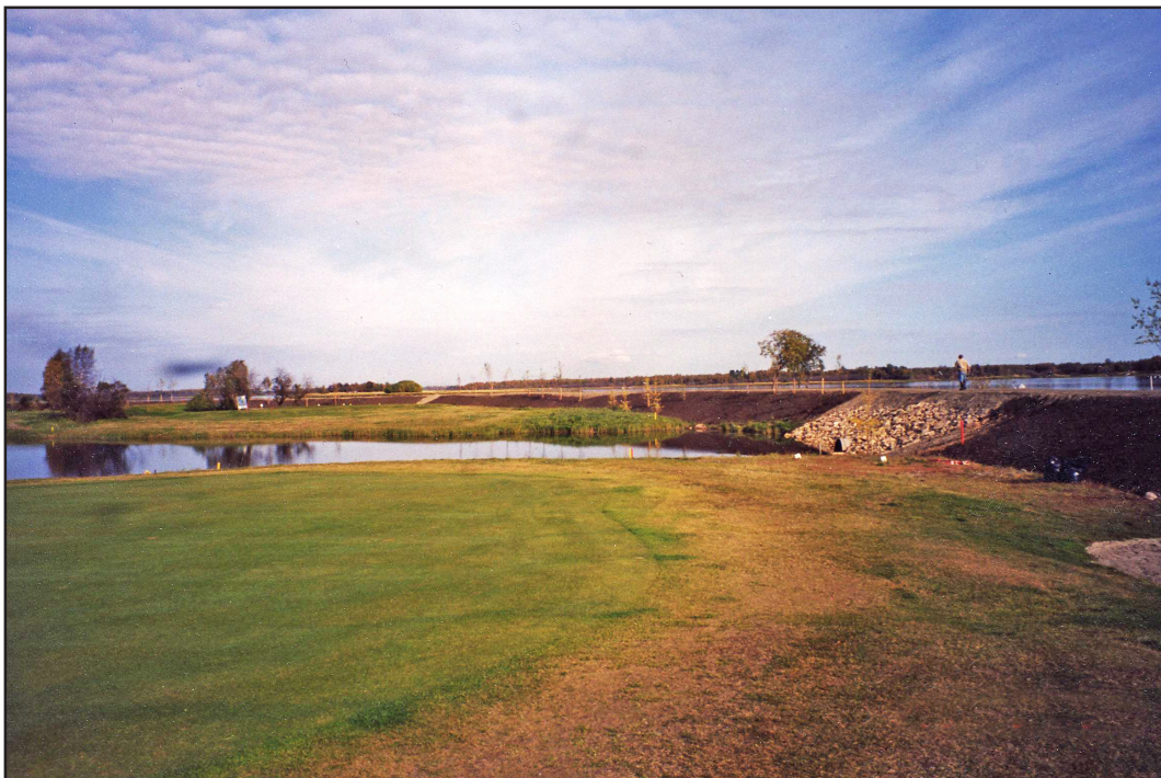
Kuva 9.2. Vasta rakennettu Tornion tulvapenger (kuva Risto Lampela)
