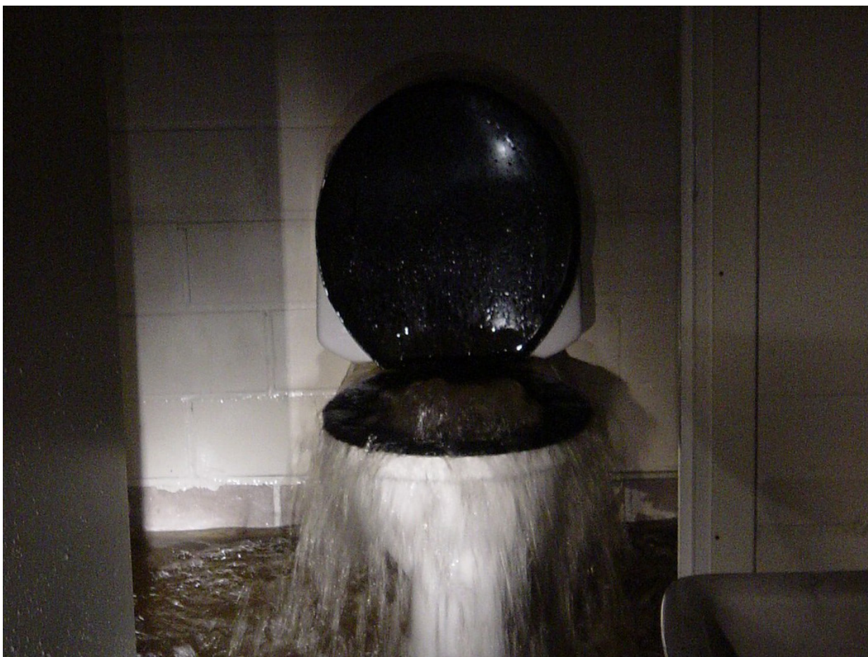
Bild 10.1. En toalettstol i källarvåningen svämmar över under översvämningen i Riihimäki (Bild Tavastlands räddningsverk 2004).
