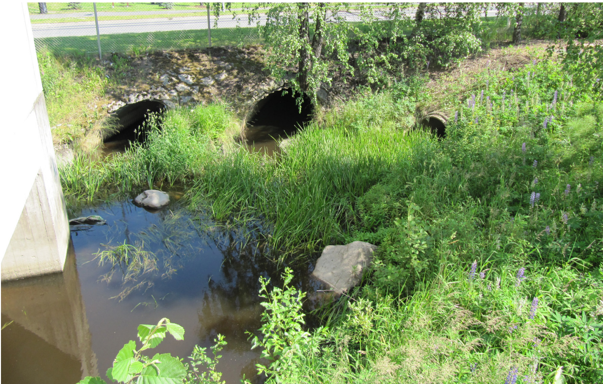
Bild 10.4. Brotrummor på Puistokatu i Kulmala. Under översvämningen år 2004 måste man också pumpa vatten över vägen (Bild NMT-centralen i Tavastland 2014).
