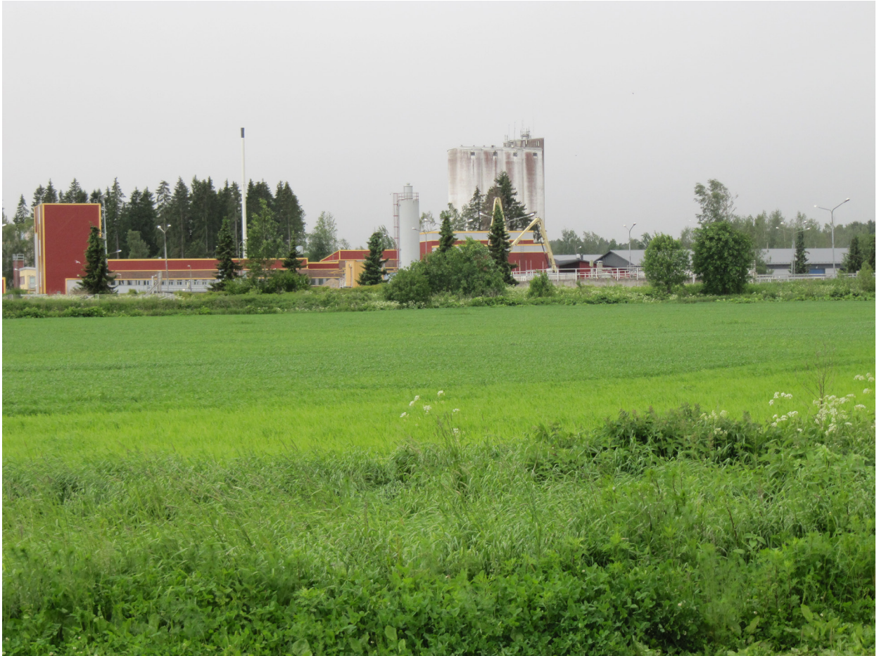
Bild 9.2. Avloppsreningsverket i Riihimäki (Bild NMT- centralen i Tavastland 2014).
